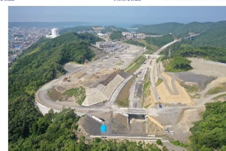
⑧串本IC仮称(道路改良)
