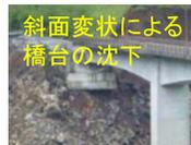
（大規模な斜面崩壊による橋台の沈下等の事例が存在したため、地質・地盤調査、橋の設置位置等について考慮する必要）
