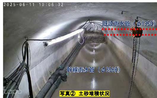
写真② 土砂堆積状況
