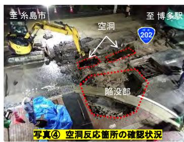
写真④ 空洞反応箇所の確認状況
