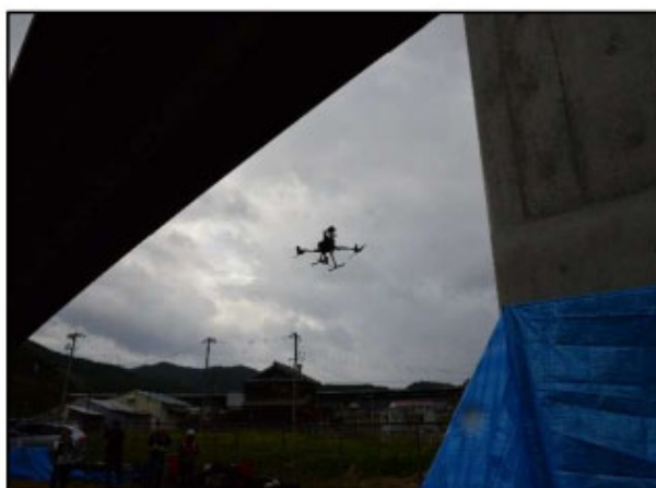
【ドローン・AIを活用した 橋梁点検・調書作成支援業務】
