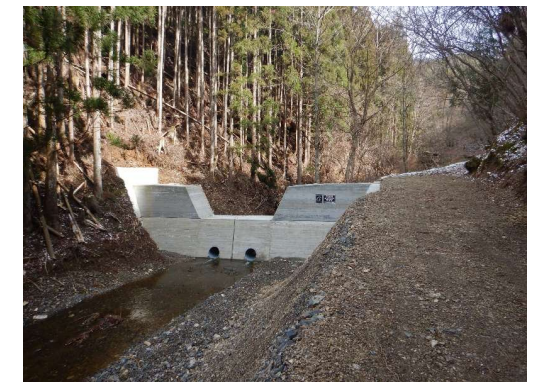
溪間工事の例
