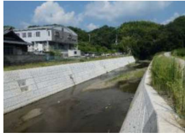
【柘榴川 築堤・河道掘削】
