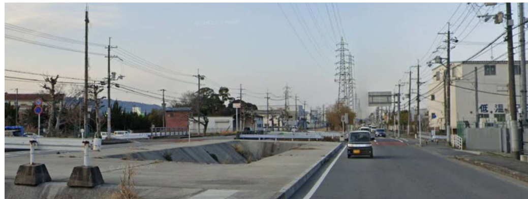
大和中央道整備に伴う調整池（約3600m 2 の開発）【道路】
