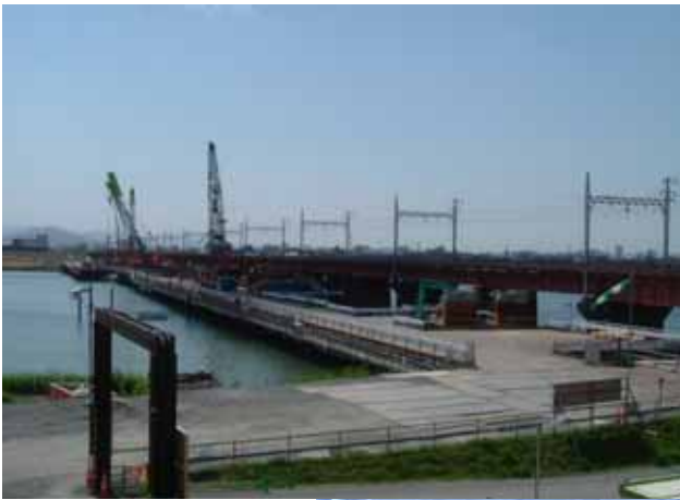
J R 阪和線の 橋梁架替工事 (平成17年3月撮影)
