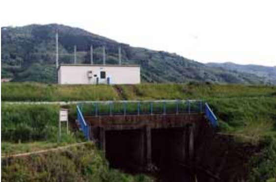
改築を行う桜谷川樋門
