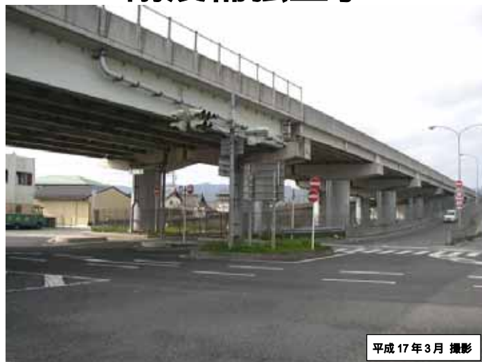
でじま 国道24号 出島高架橋
