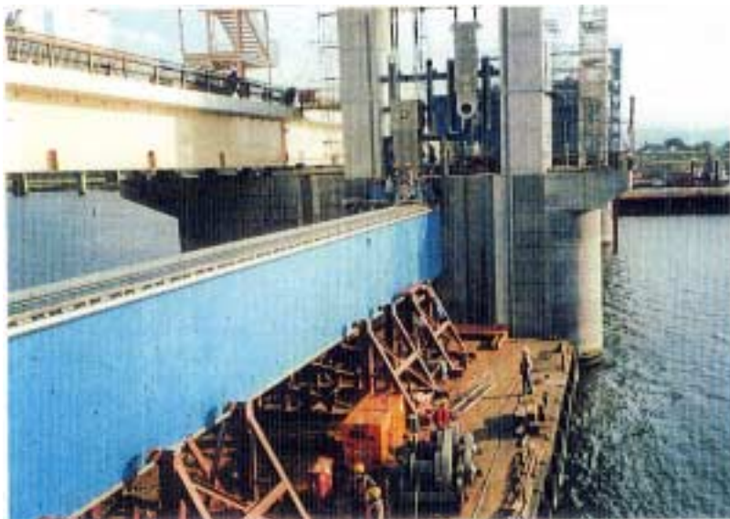
ゲートとシーブブロック連結作業中
