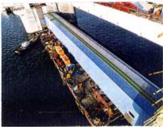
堰柱間への進入状態
