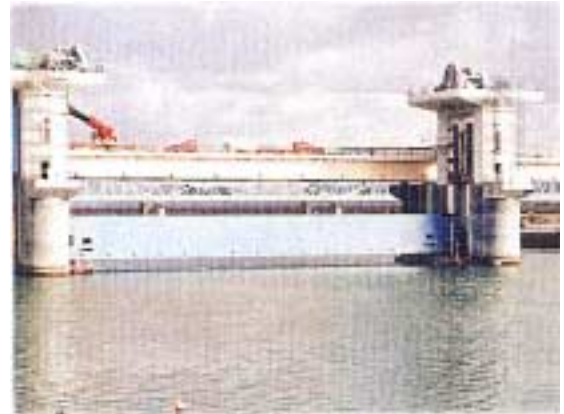
扉体架設ステージング上仮置状態
