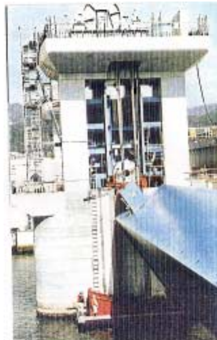
扉体立越作業中
