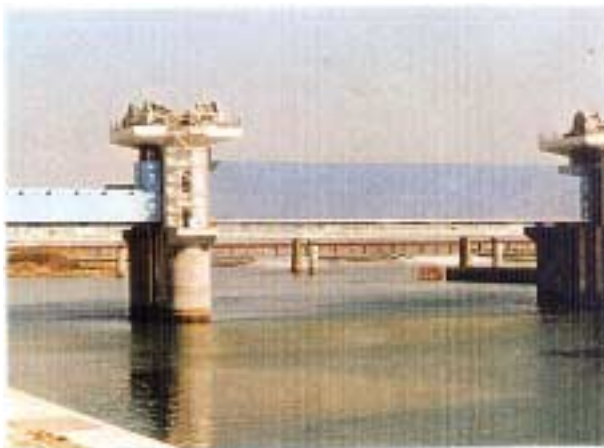
吊り上げ完了
