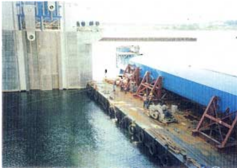
堰柱間への進入状態
