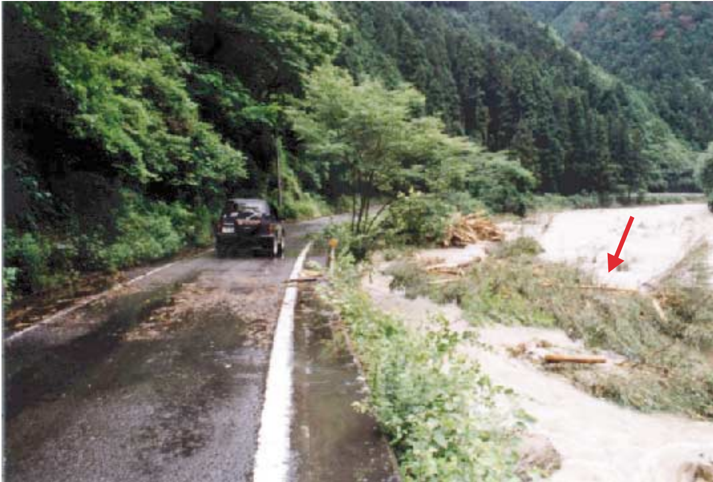
北又橋下流500m付近での流木・出水の状況
