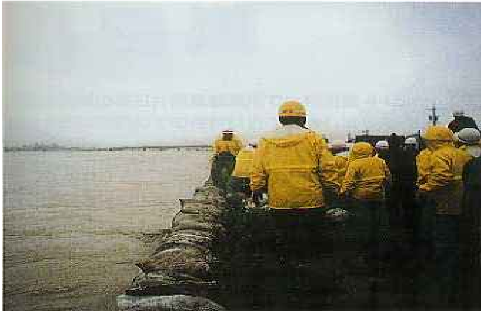
積み土のう工
