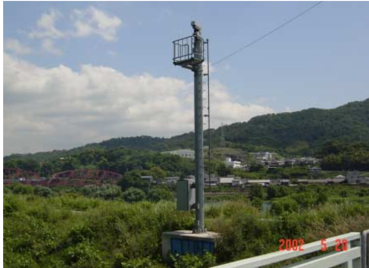
CCTVの設置状況(右岸岩出橋付近)
