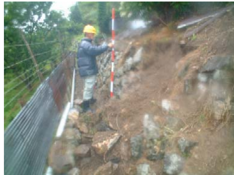
④ 6月17日 民家西側の畑石積み崩落
