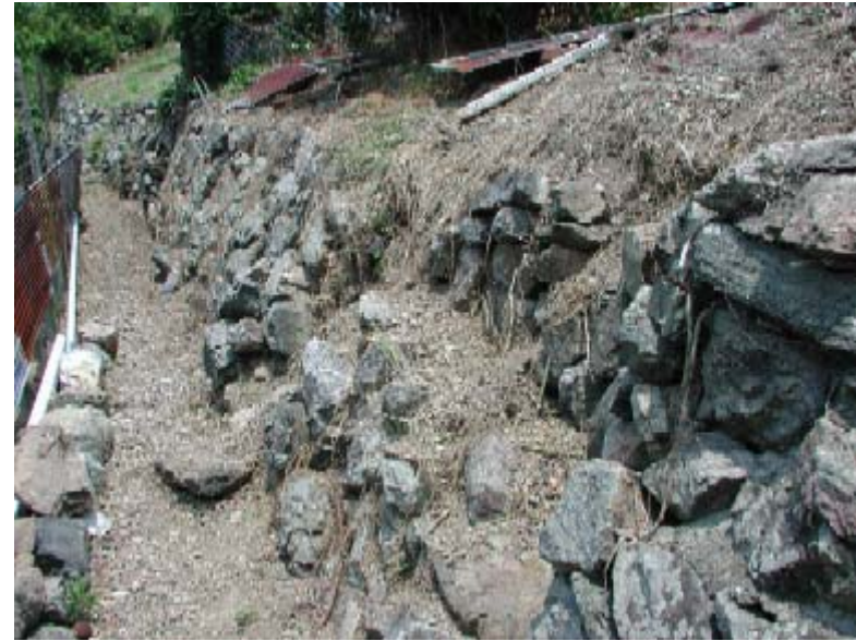
② 6月1日 民家西側の畑石積み一部崩落
