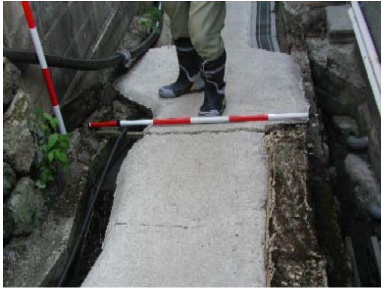
① 5月9日 道路上のモルタルの開口亀裂
