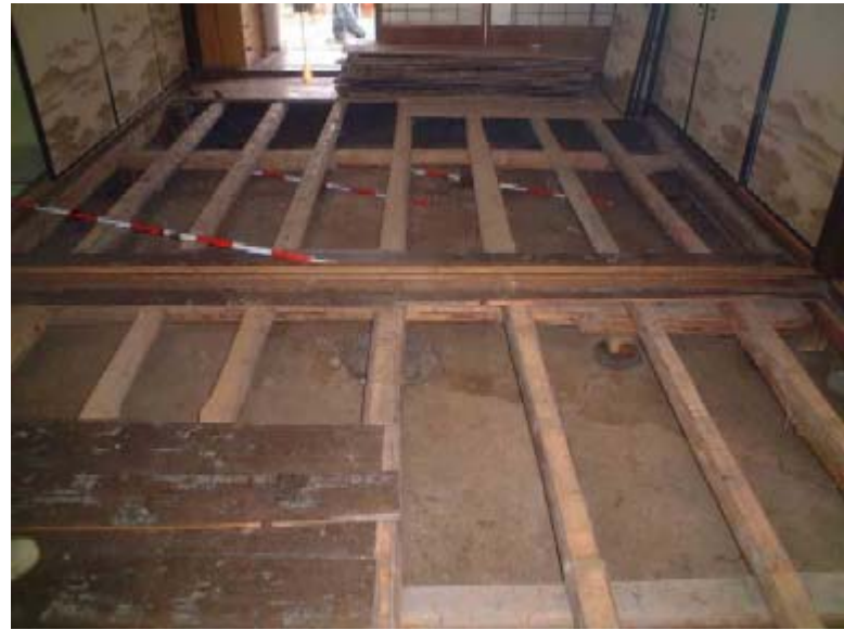
⑧ 6月25日 民家床下の亀裂
