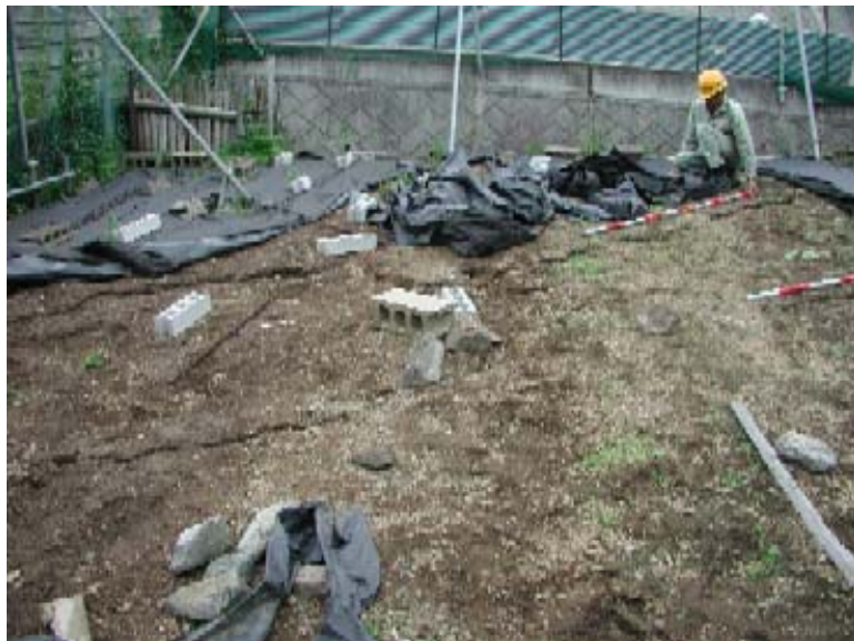
③ 6月12日 集水井W2西側 畑の亀裂
