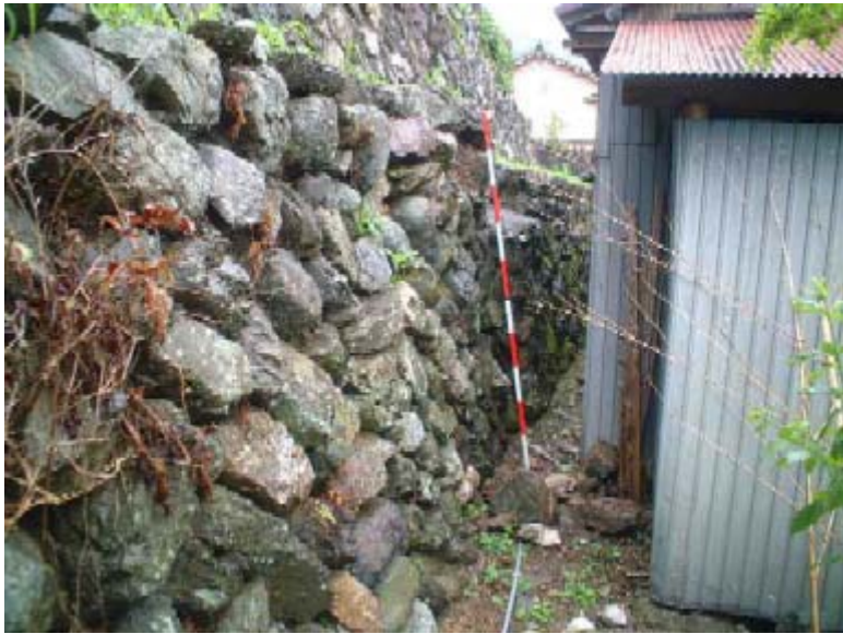
⑦ 6月25日 民家北側の石積み崩落
