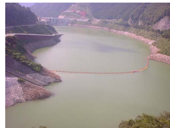
▲網場設置の様子(大滝ダム)
