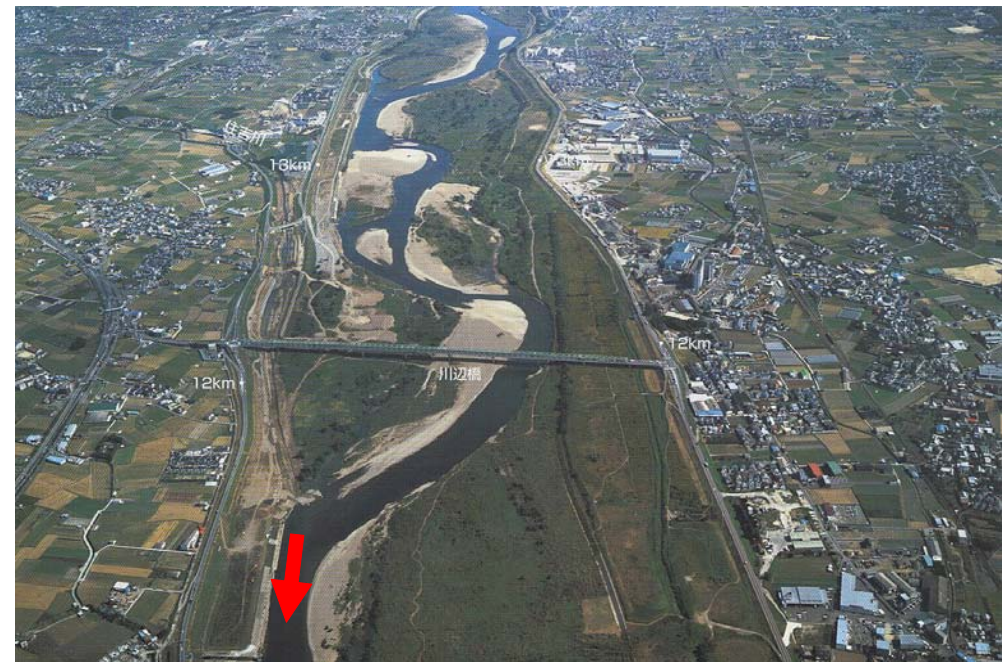
▲連続する瀬と淵(12.0k付近)
