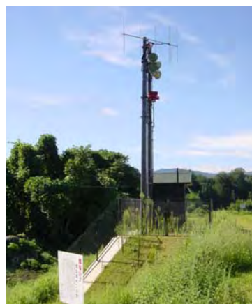
写真 4.4.7 大滝ダム警報局
