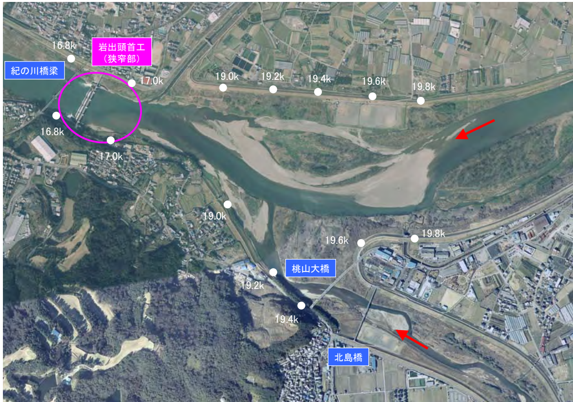
写真 4. 1. 2 河道の整備（和歌山県岩出市）
