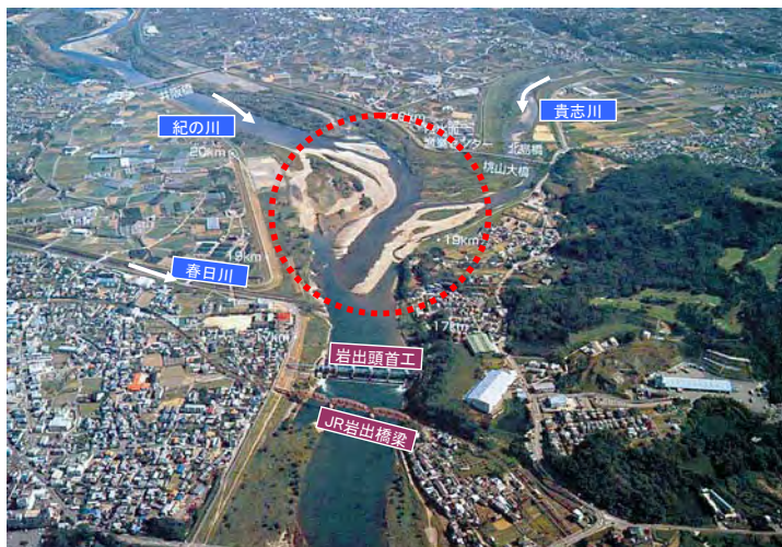
写真 2.1.1 岩出頭首工上流の土砂堆積状況
