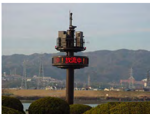
写真 4.4.6 紀の川大堰警報局及び電光表示板
