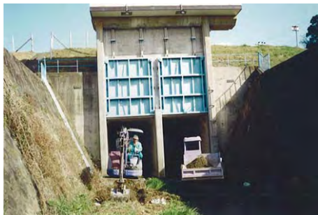
樋門周辺の土砂撤去
