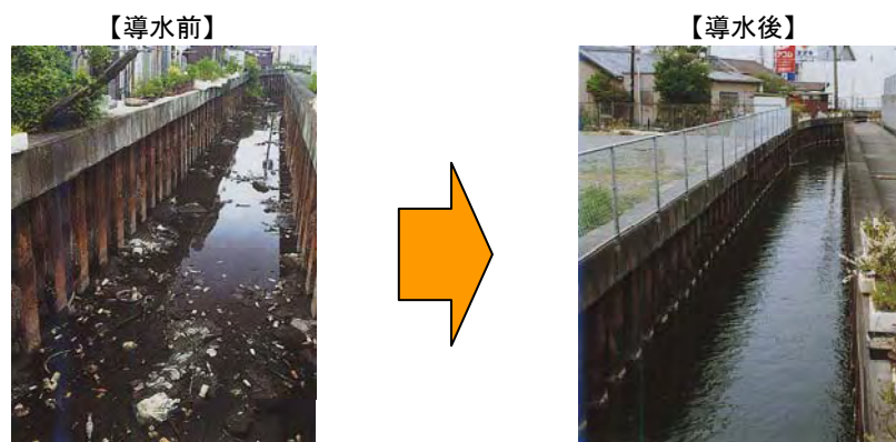
写真 2.3.9 有本揚排水機場の効果（有本川）
