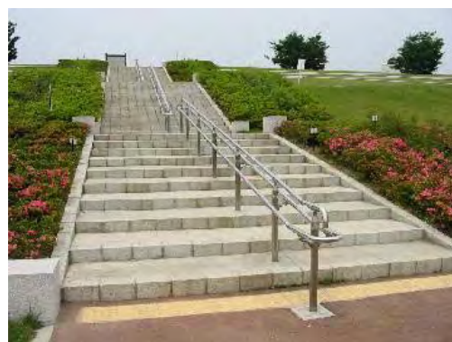
写真 4.3.3 手すり付きの階段
