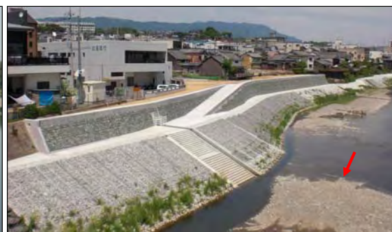
写真 4.3.5 整備後（橋本橋直上流）
