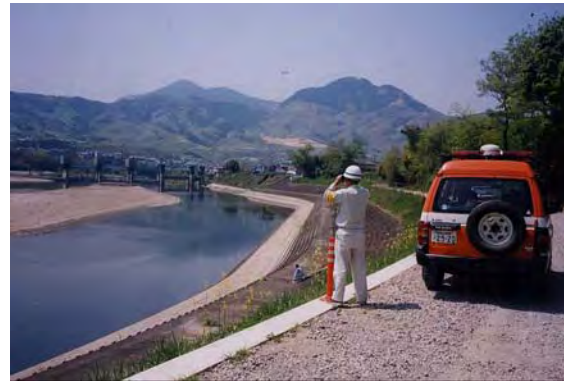
写真 4. 4. 5 河川巡視の様子
