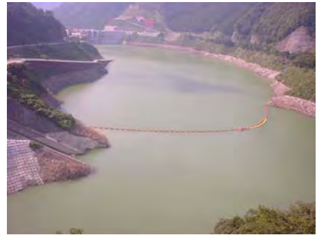
写真 4.4.8 網場設置の様子（大滝ダム）
