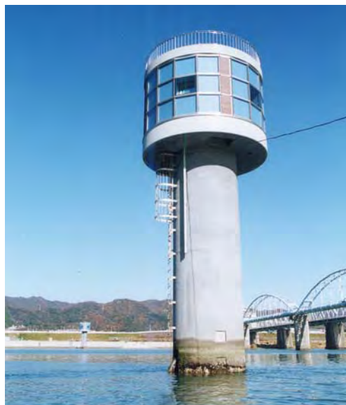
写真 2.4.6 紀の川大堰-水質監視
