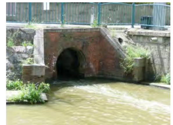
▲築留二番樋(堤防の向こう側が大和川)
