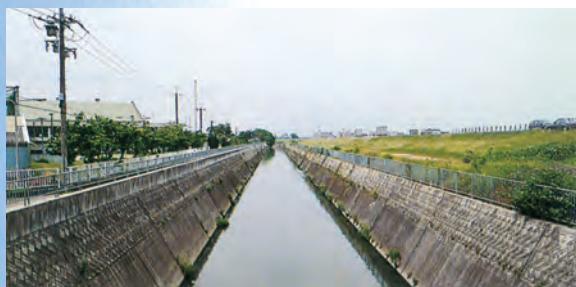
▲落堀川 右の土手は大和川の堤防
