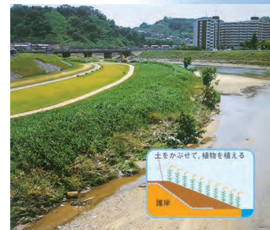
▲多自然川づくり
