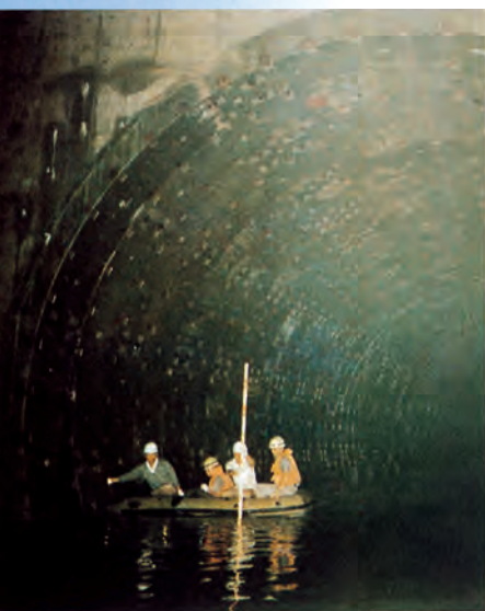
▼寝屋川南部地下河川
