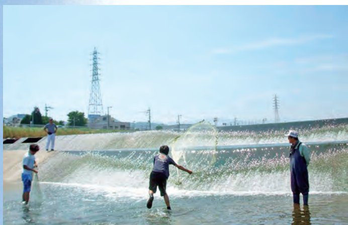
▲2015（平成27）年5月 松井井堰 投網で生き物調査を する高校生
