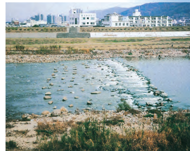
▲瀬と淵じょう化しせつ (大阪府柏原市)
