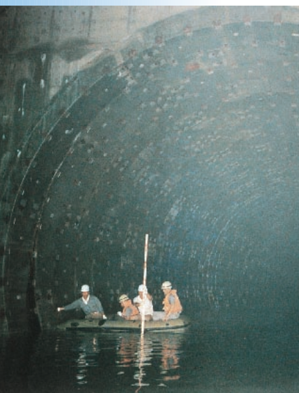
▼寝屋川南部地下河川
