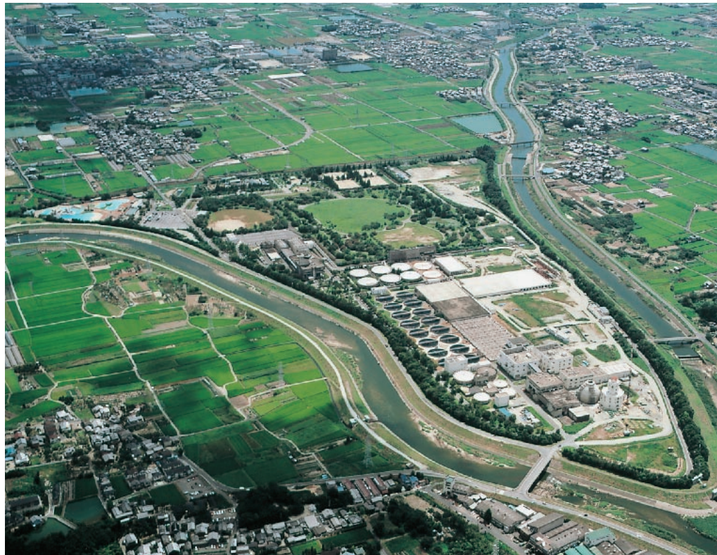
▲じょう化センター (奈良県大和郡山)
