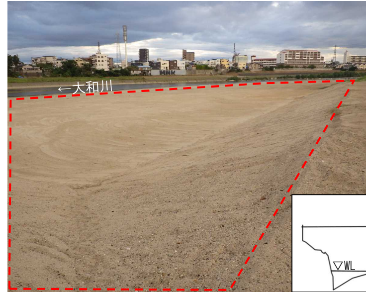
掘削後（遠里小野地区）
