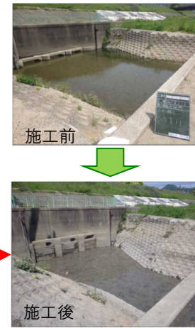
青地樋門前 維持掘削状況 (平成30年度実施)
