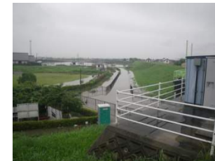
⑤ 浄化施設付近 (16時半頃)
