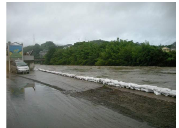
土のう積み完了
