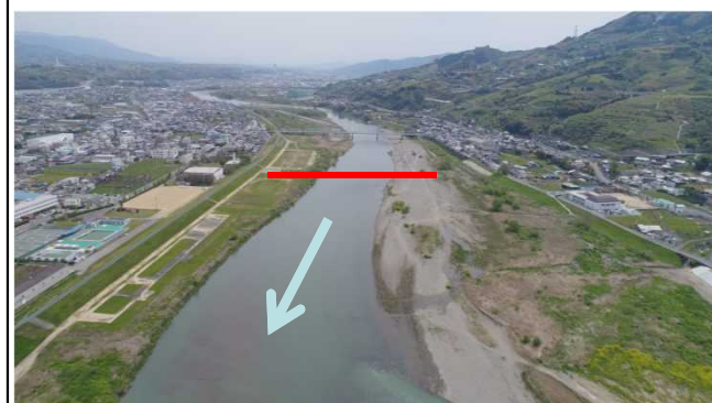
三谷水位観測所 断面位置
