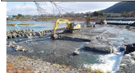
6号井堰撤去前(平成28年12月)
