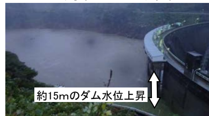
洪水調節前の22日17時頃のダム堤体上流面
