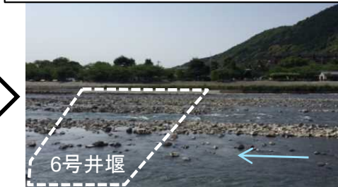
6号井堰撤去後(平成29年5月)
