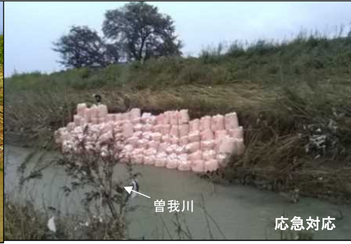
曽我川右岸1.8k 低水護岸損壊 L=160m
