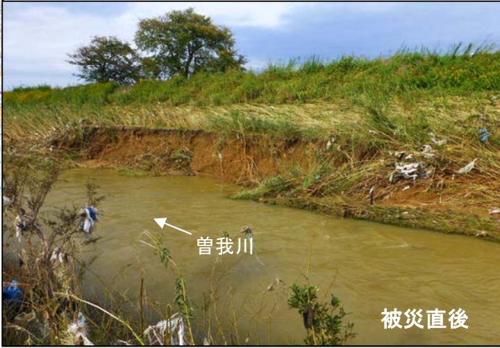
曽我川右岸1.8k 低水護岸損壊 L=160m
