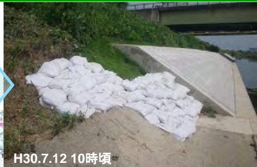
護岸損傷＜佐保川右岸7.4k(大和郡山市)＞
