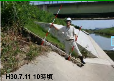
護岸損傷＜佐保川右岸4.2k(大和郡山市)＞
