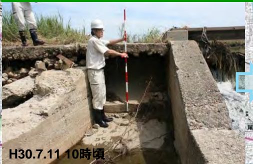
護岸損傷＜佐保川右岸4.2k(大和郡山市)＞
