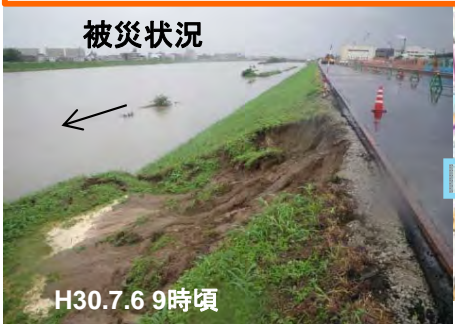
堤防法崩れ＜大和川左岸7.2k(堺市北区)＞
