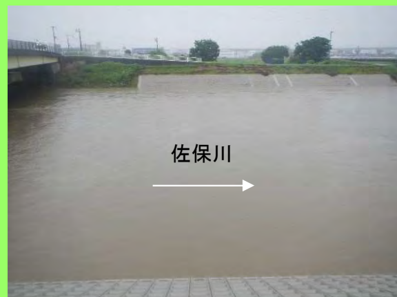
出水時(佐保川旧長安寺井堰周辺)
