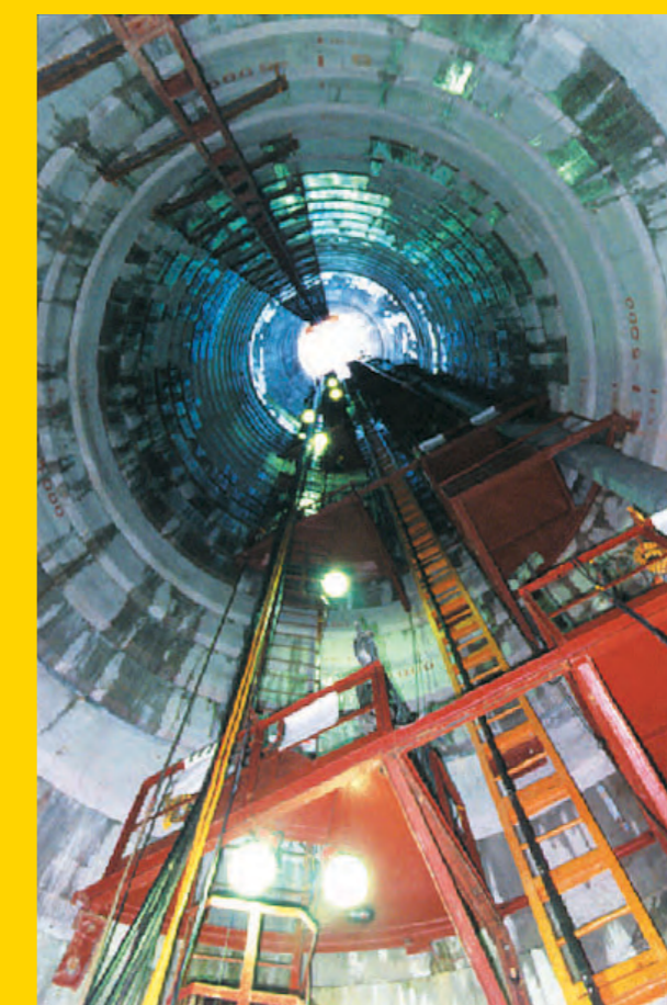
施工中の深礎工内部
