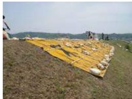
洗掘対策として、堤防が壊れるのを防ぐ工法
