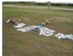
漏水対策として、堤防から吹き出した水を安全に排出する工法
