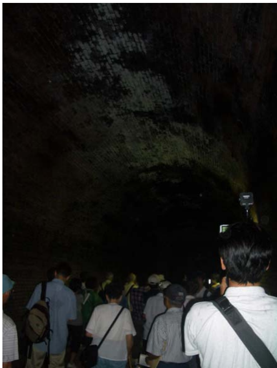
旧国鉄関西線の亀の瀬トンネルの見学の様子。
