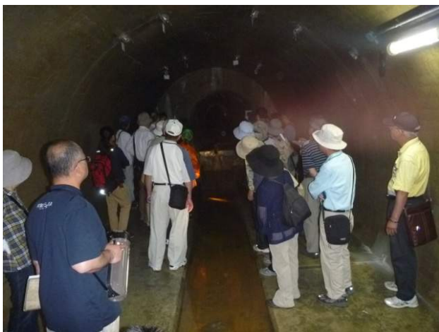
排水トンネルでの説明状況
