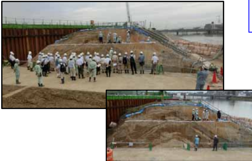
現地調査の様子
