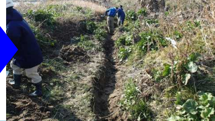
ワンド機能向上の為の水路掘り！スコップを用いて人力で作業しました！
