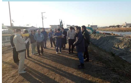
大堀地区低水護岸工事
