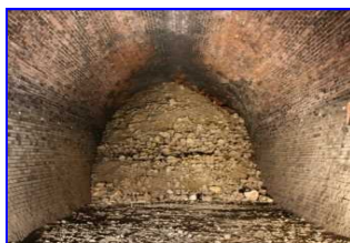
旧大阪鉄道亀瀬隧道
