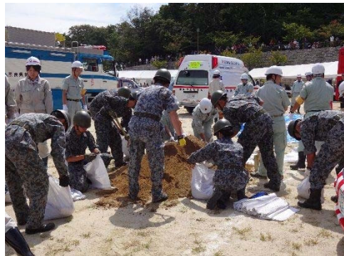
土のう作製・積み土のう設置
