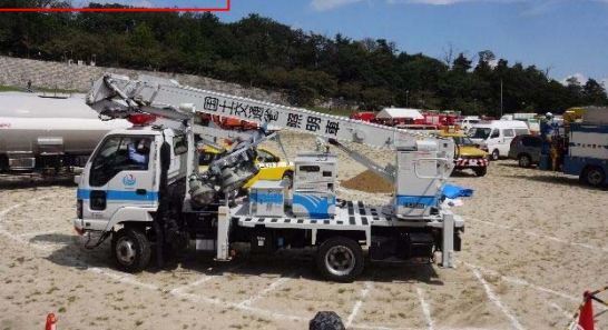
夜間作業を想定し照明車を設置
