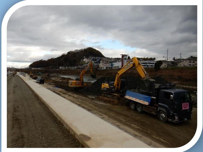
掘削した土砂を運搬してる様子
