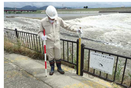
転落防止柵の高さ確認
