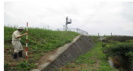
堤防の危険箇所の有無を確認中
