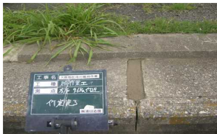
階段の隙間にモルタル注入
