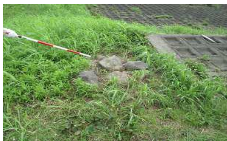
崩れた石積みを補修
