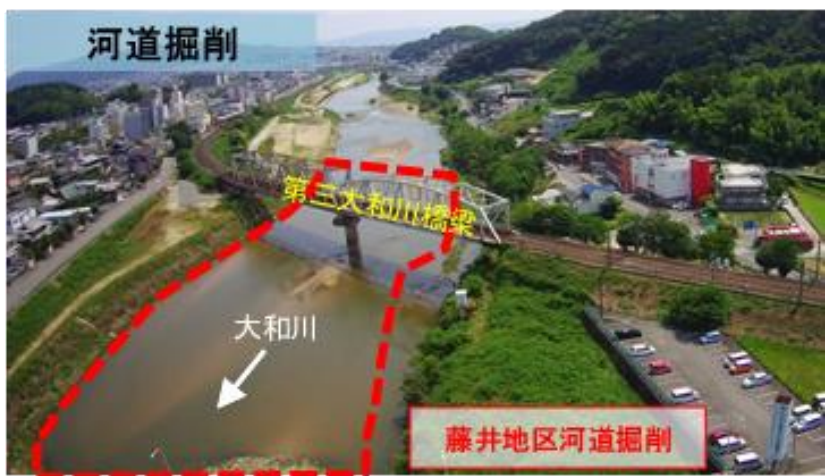
河道掘削(藤井地区)
