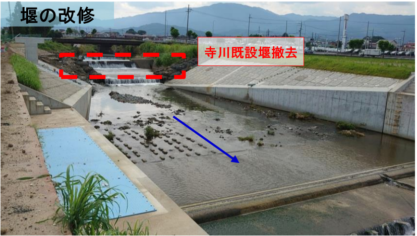
寺川堰撤去(桜井市大福工区)
