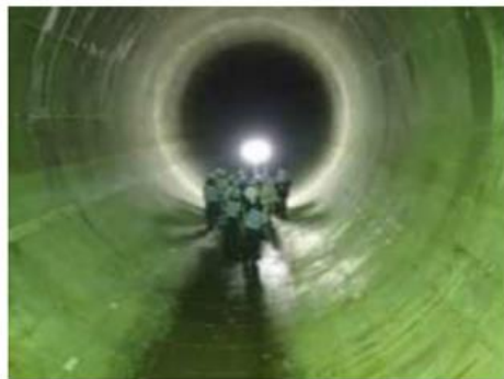
雨水貯留管の整備
