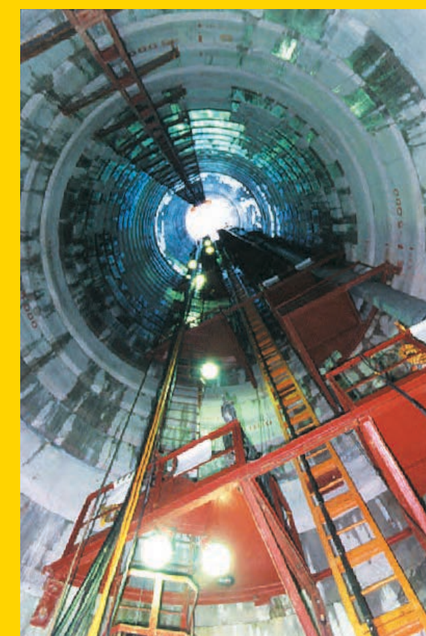
施工中の深礎工内部
