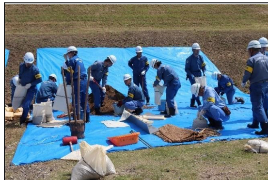
大阪市建設局による水防工法施工
