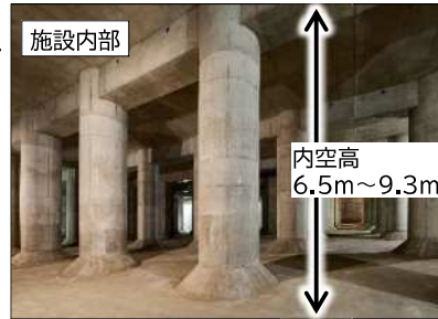
地下貯留施設（三郷町惣持寺調整池）
