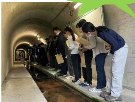
排水トンネル
