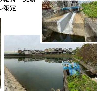
ため池の治水利用（上牧町 中山谷池）
