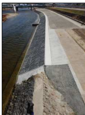
護岸の損傷箇所を 復旧
