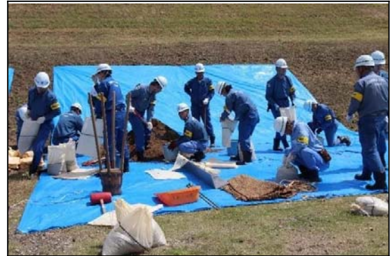
大阪市建設局による水防工法施工
