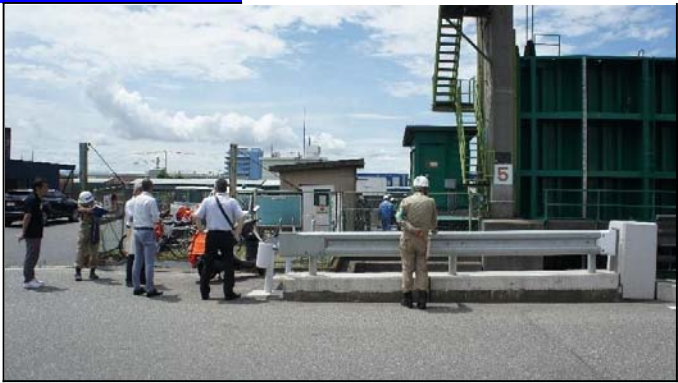
住之江区 水門開閉操作
