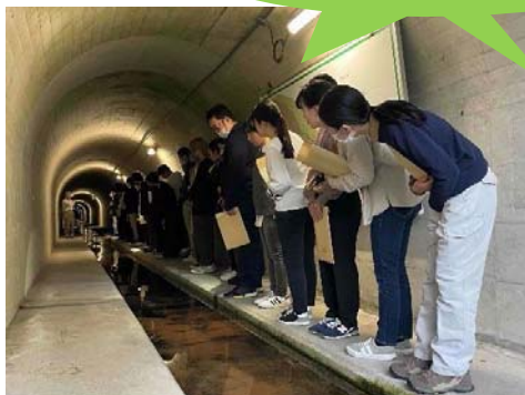
排水トンネル
