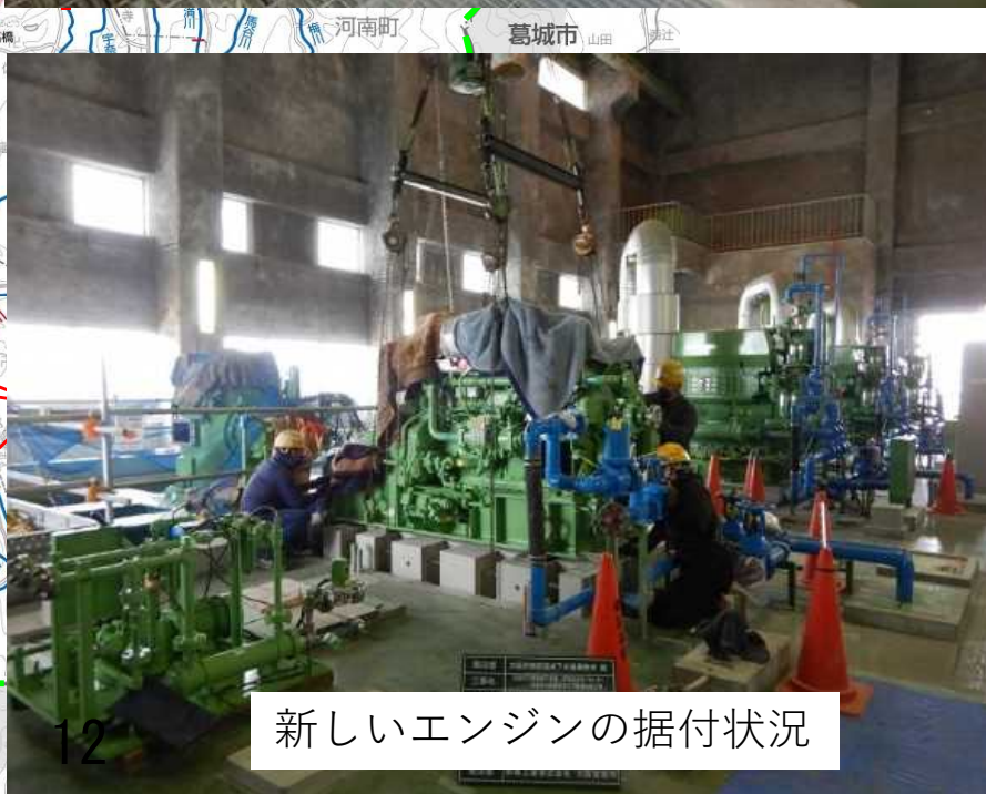
古いエンジンの撤去状況
