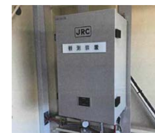
IPテレメータ観測装置設置
