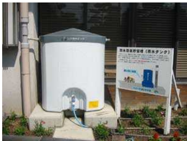
雨水タンク設置状況
