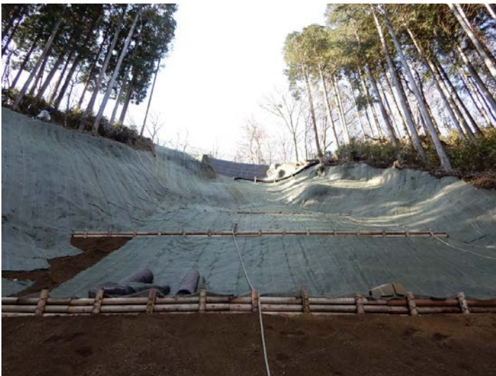
(災害復旧：山腹工)
