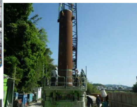
鋼管杭打設状況
