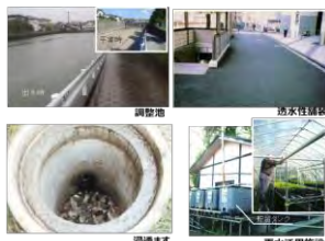
雨水貯留浸透施設の例
