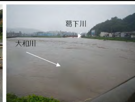
出水時（大和川27.0k付近）
