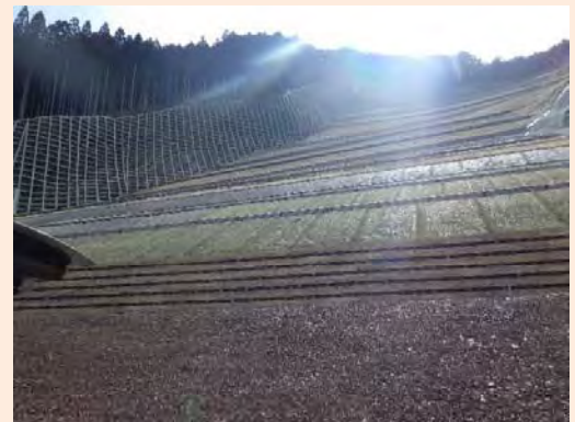
▲【R2.3完成 天川区域 坪内】
