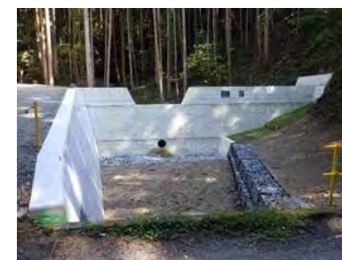
【治山：溪間工（治山ダム）】
